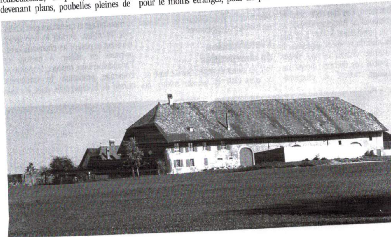
La ferme du Château de Vullierens.
