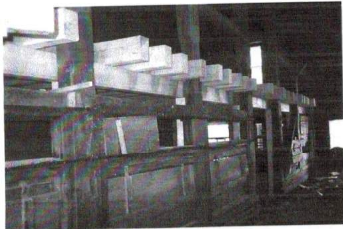
La majeure partie des matériaux a été récupérée.
